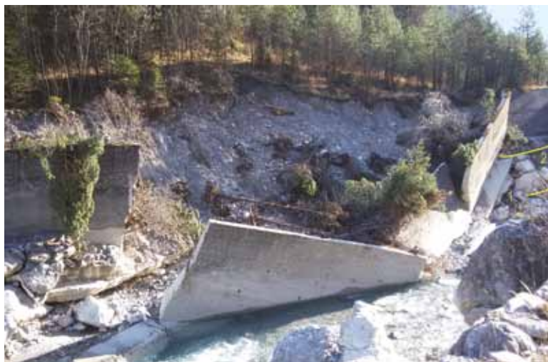
Fig. 28. Una inopportuna riprofilatura del letto del T. Aupa, con forte approfondimento di questo settore per evitare esondazioni subito a valle, vi ha innescato una serie di processi erosivi, che sono del tutto normali e prevedibili in un torrente. Così si è determinato il grave dissesto: intervento di riprofilatura → erosione risalente del letto e suo approfondimento di circa due metri → venuta alla luce delle fondazioni dei muri di sponda → loro sottoescavazione e crollo finale → erosione della scarpata retrostante. Le linee gialle indicano rispettivamente: 1. la base della originaria scogliera a protezione delle fondazioni dei muri spondali; 2. l'originario livello del letto del T. Aupa.
