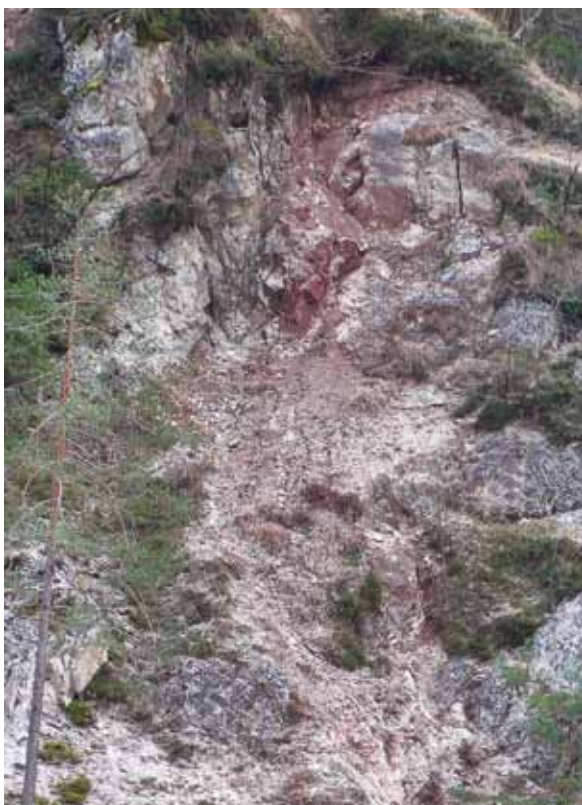
Fig. 2. Rocce carbonatico-terrigene della Formazione di Werfen, intensamente fratturate nella zona di movimento della faglia Fella-Sava (versante destro della Val Pontebbana). Gli strati sono verticali.
