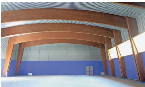
Nuova palestra in costruzione.
