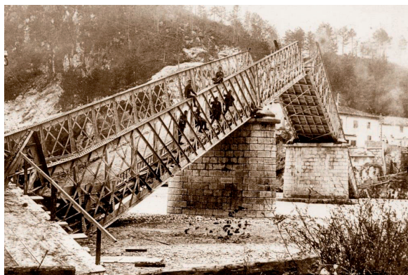
Fig. 5. La fotografia alla gelatina ai sali d'argento, realizzata dalle truppe austro-ungariche nei primi giorni di novembre del 1917, mostra ciò che resta del ponte in ferro sul fiume Fella fatto brillare dai reparti del Genio in ritirata alle ore 19 del 29 ottobre 1917 (ASFM, id. GG283, Fondo Bavecchi Andrea).
