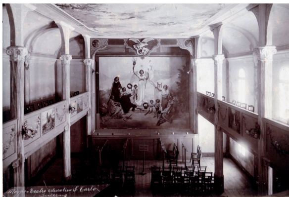
Fig. 3. Fotografia al citrato virata all'oro, realizzata da Giovanni Strano nel 1913, che illustra l'interno del Teatro San Carlo ripreso dal loggiato centrale. Il teatro, inaugurato il 26 dicembre 1913, viene costruito dalle maestranze locali che offrono il proprio lavoro coadiuvate dalle braccia di tutta la popolazione (ASFM, id. GG160; 0002-0192, Fondo Deganutti Ottavo, eredi).
