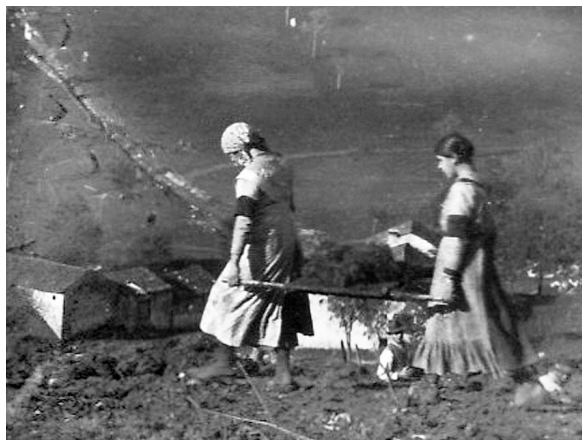
Val Aupa, Studena Alta, portatrici intente a rimuovere terra dalla trincea. Si noti la fascia al braccio.
