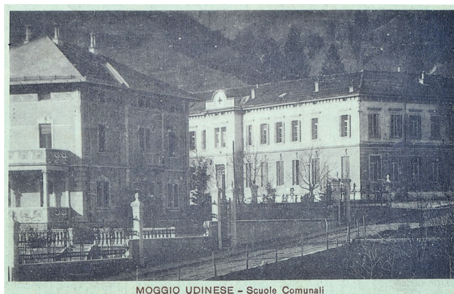
Le vecchie scuole elementari vengono costruite nel 1903-1904 su progetto dell'ingegner Giobatta Calligaris di Tolmezzo ed edificate dall'impresa di costruzioni Domenico Piemonte di Buia. A sinistra villa Franz costruita nel 1913 (coll. B. Lucci).
